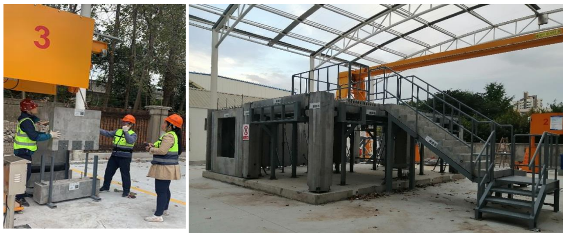
上图：新建装配式建筑实训基地
